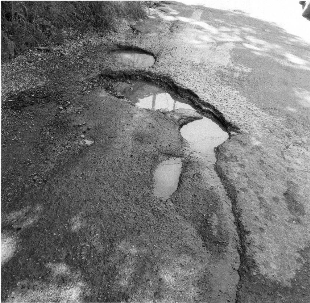
MANUTENÇÃO ASFÁLTICA na Rua Augusto Belizário em frente ao número 399- Vila Pomar, Mogi das Cruzes.
